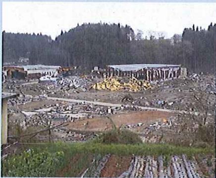
←被害を受けた水産加工工場
